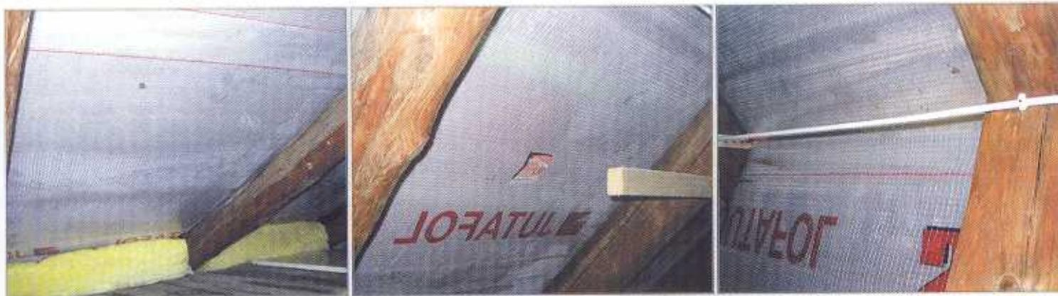
(фасадах домов каркасного типу) використовують плівки, які захищають утеплювач не стільки від намокання, скільки від вітру. Вже при швидкості вітру 4 м/с теплове опірність стіни з незахищеним утеплювачем падає майже втричі. А в навісних вентиляруваних фасадах гуляють такі потоки повітря, що незахищений утеплювач просто-напросто видавлює в течение нескількох років.
